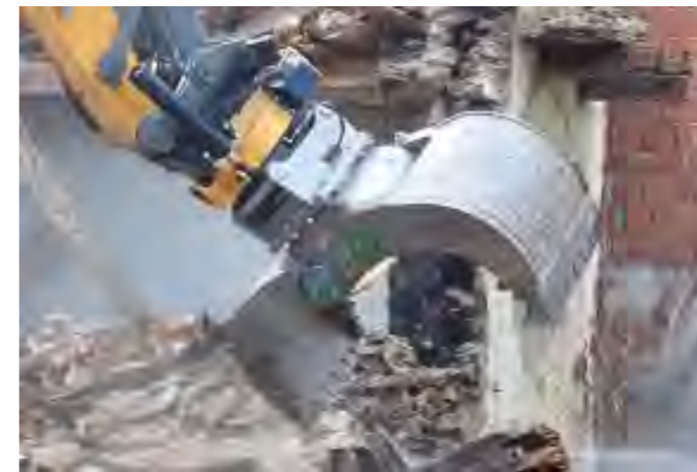
Modularis-Greifer mit Kipprotator 360-Anschluss
