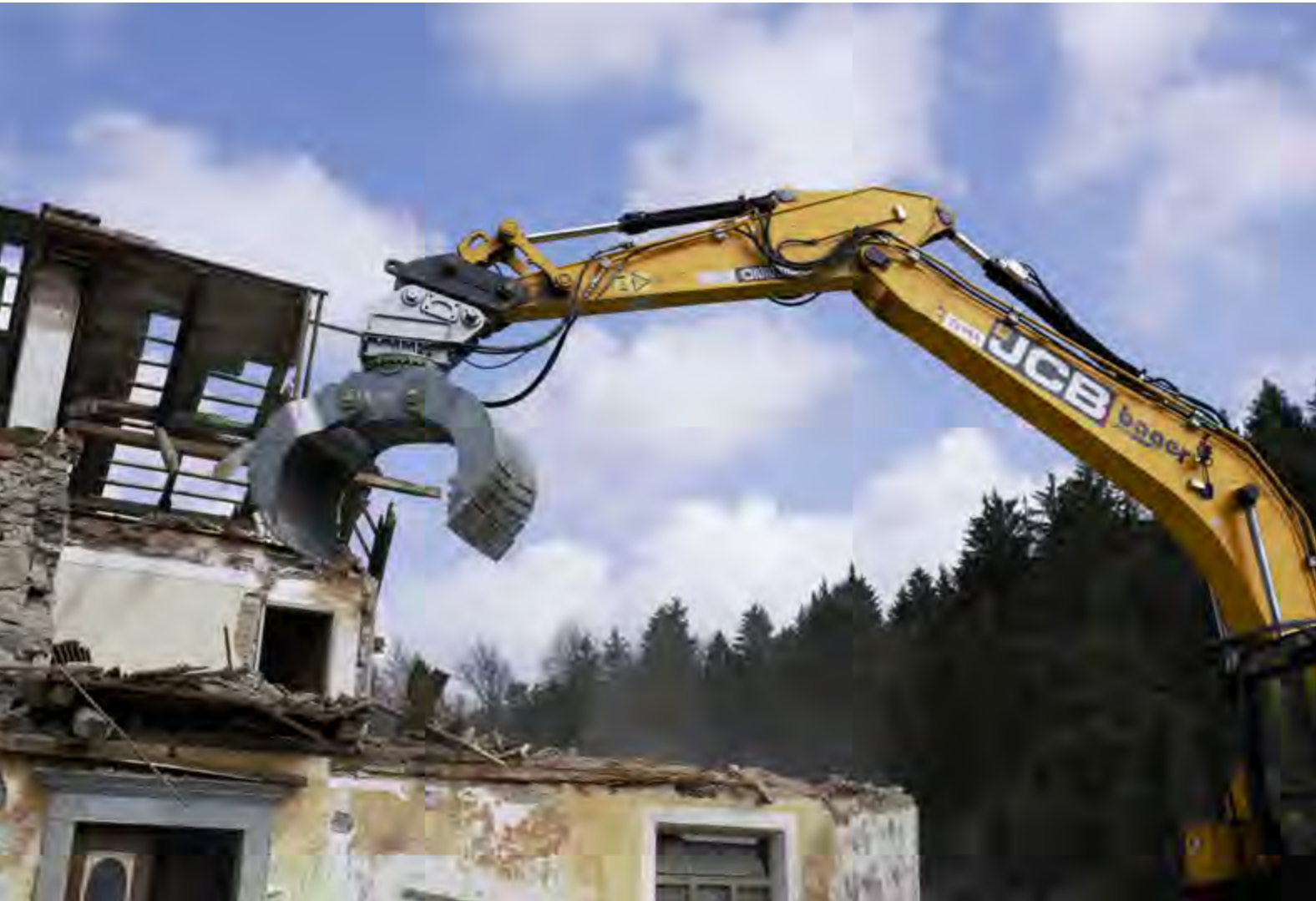
Hocheffizientes Werkzeug für den Abriss von Gebäuden - Best Grip Greifer
